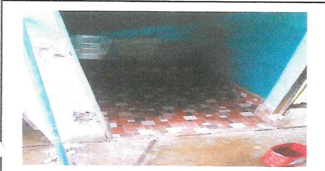
Foto1: inicio de trabajos en colocacion del piso ceramico para los baños.
