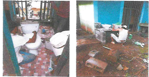
Foto 4: inicio de trabajos de sustitucion de inodoros y lavamanos
