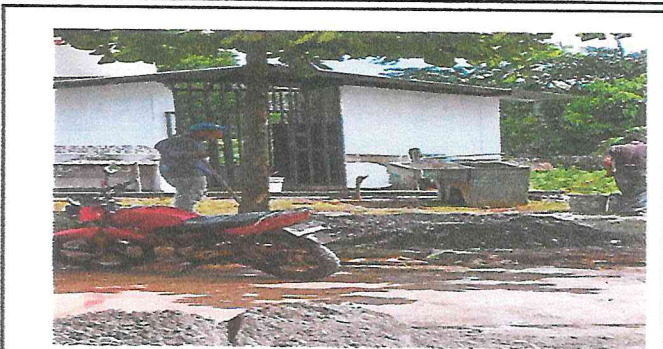
Foto 2: inicio de trbajos en base de cemento para la instalcion de la pila
