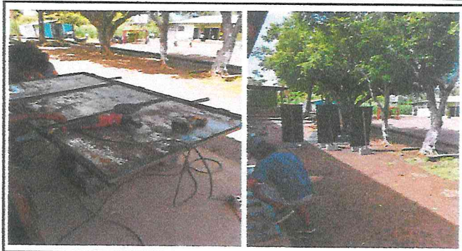
Foto 2: inicio en trabajos de sustitucion de puertas de aulas.
