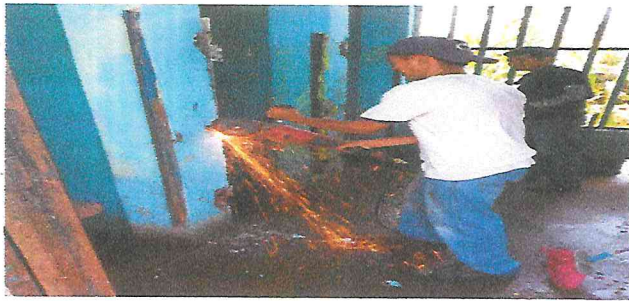
Foto 3: inicio de trabajos en sustitucion de puertas de baños
